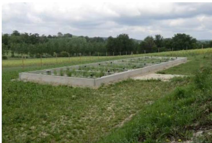
Figure 11 : Station d'épuration d'Andiran, source Eau 47
