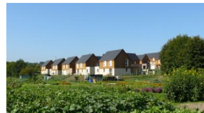
Arelaune en Seine (76) Eco-quartier de l'église 24 logements individuels dont (8 locatifs)
