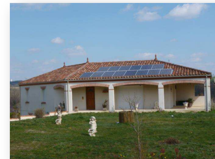
Habitat pavillonnaire présentant des panneaux photovoltaïques sur la toiture, secteur de Martin, © UrbaDoc, 2013
