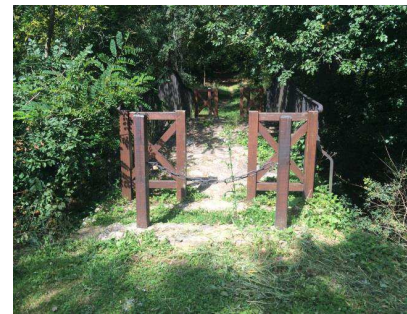
Pont en pierre, secteur Moulin Neuf, domaine public, voie communale n°201 dite de Moulin Neuf, section 0A
