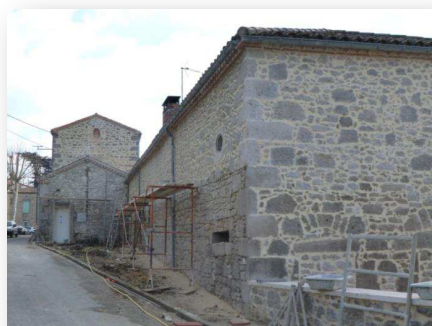
Bâtisse en cours de rénovation dans le centre ancien, Photographie © UrbaDoc, 2013
