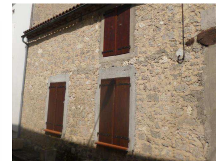
Ouvertures à la française dont les encadrements sont soulignés par l'utilisation de pierres avec enduits, Photographie © UrbaDoc, 2013
