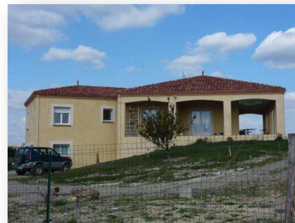
Présence de génoise au niveau de la toiture, construction en R+1, Montauzet, © UrbaDoc, 2013
