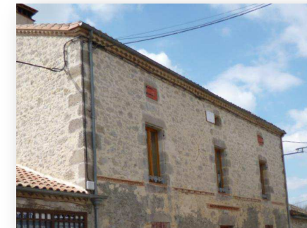
Toit à deux pans avec présence de génoise, Photographie © UrbaDoc, 2013
