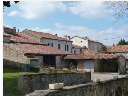
Toiture deux pans avec utilisation de la tuile canal, Photographie © UrbaDoc, 2013
