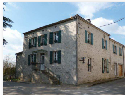
Unité bâtie traditionnelle avec des ouvertures à la française, Photographie © UrbaDoc, 2013
