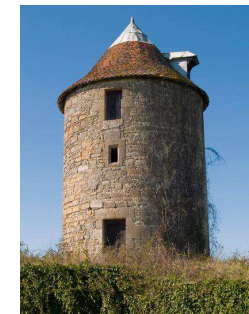
Moulin dit de Coulaqué, secteur le Moulin, p.l.e. n°280, section 0B
