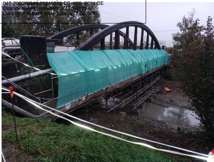
Réparations sur le Pont de Madonne à Montesquieu
