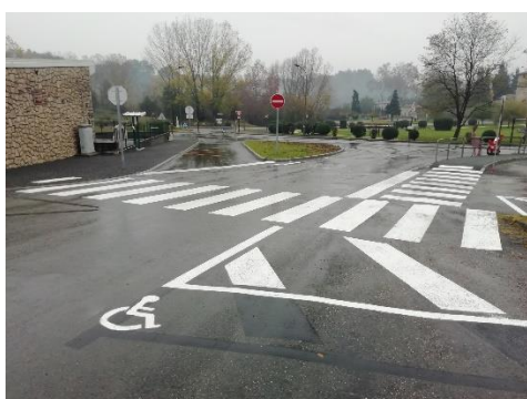
Sécurisation école de Vianne
