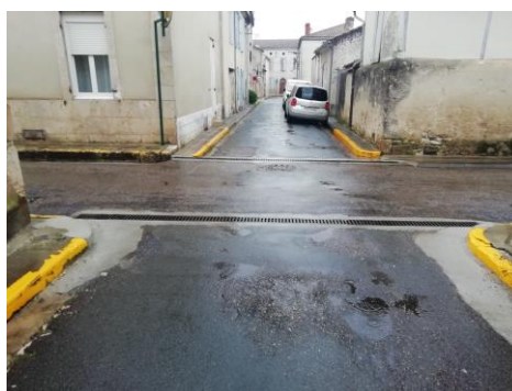
Caniveau rue du Temple à Lavardac
