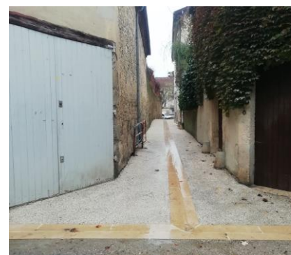
Réfection rue du Prince à Nérac
