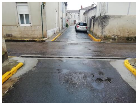
Caniveau rue du Temple à Lavardac
