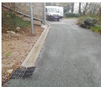
Reprise d'un caniveau à Fieux
