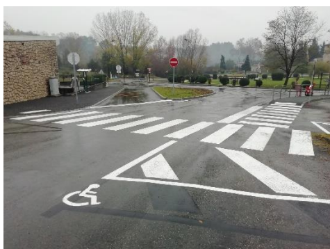
Sécurisation école de Vianne
