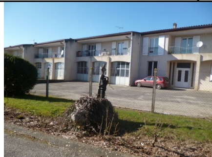
Logement mitoyen en R+1, marge Bld. de la Mairie
