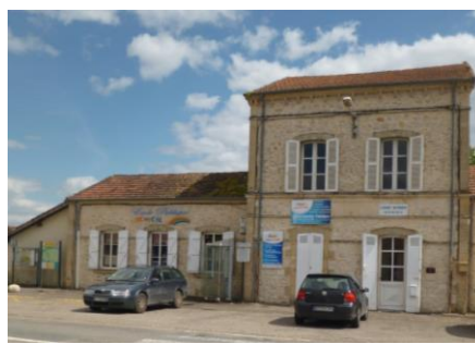
Ecole publique ; ChauffSolaire et le cabinet d'infirmiers
