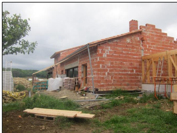
Réhabilitation en cours à Saint-Amand, © UrbaDoc 2014
