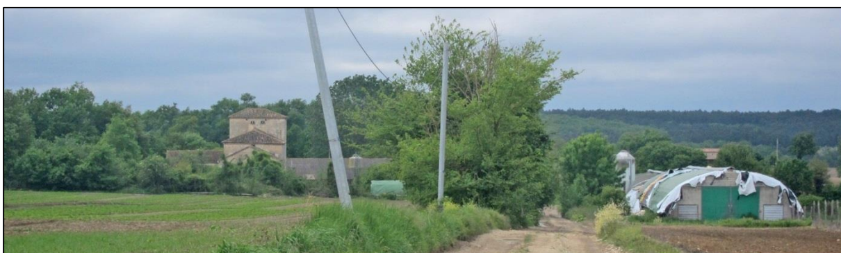
Bâtiments d'élevage avicole à Lassale, © UrbaDoc, 2014
