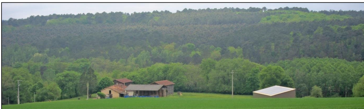
Bâtiment avec panneau photovoltaïque à Loustalot, © UrbaDoc, 2014
