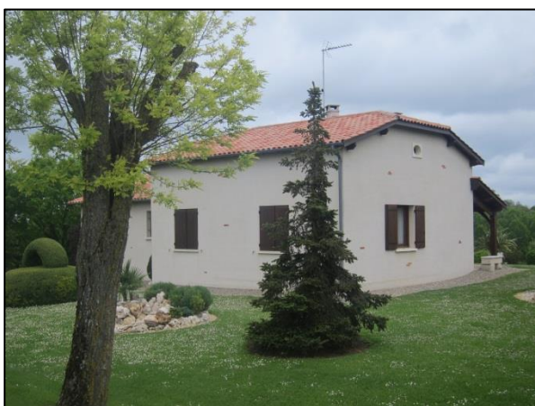
Volumétrie et toiture avec croupe inspiré du bâti agricole traditionnel, © UrbaDoc 2014
