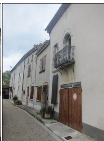
Présence récurrente de génoises dans le centre ancien, © UrbaDoc 2014
