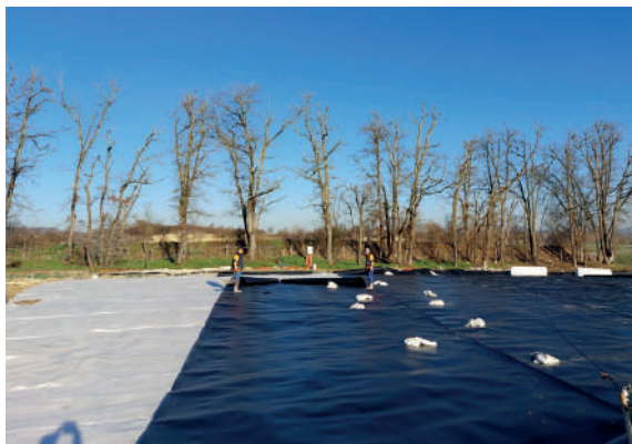
Les travaux d'étanchéité.
