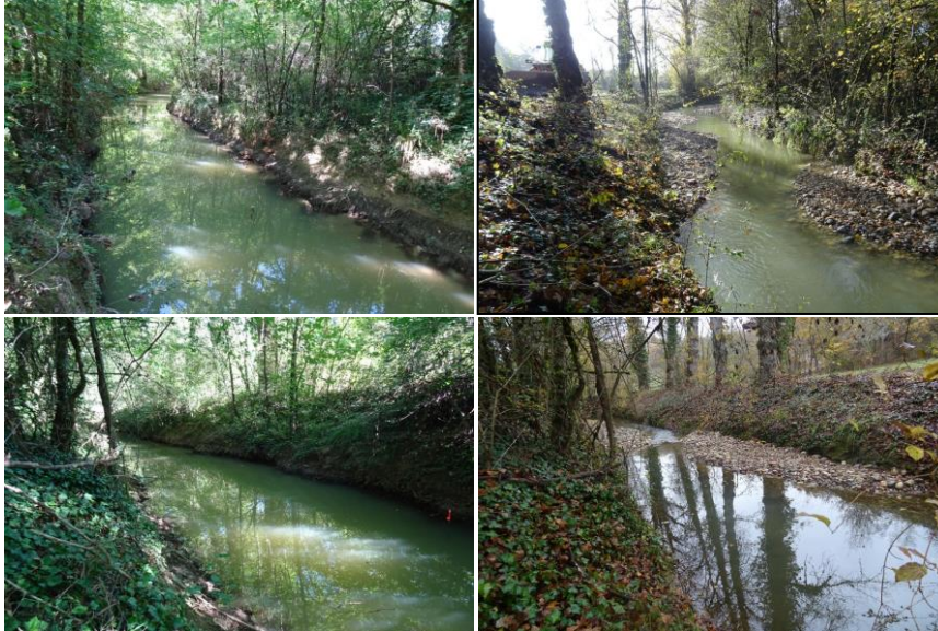
Comparatif Etat initial (photos de gauche) / après restauration (photos de droite)
