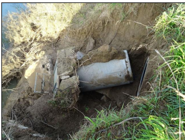
Le clapet effondré (photo de gauche) puis le clapet après réparation (photo de droite).
