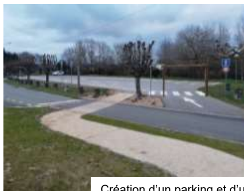
Création d'un parking et d'un cheminement piéton à Bruch
