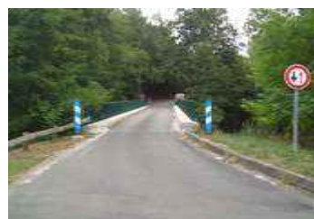
Rénovation du Pont de Cauderoue à Barbaste par AGIR
