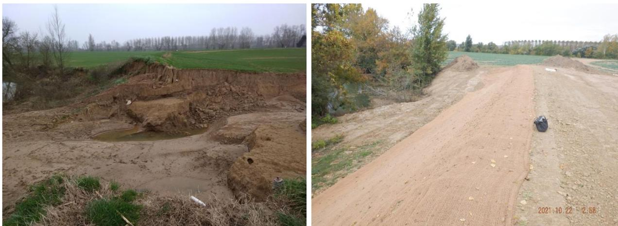
Photo de gauche : digue détruite par la crue – photo de droite : digue après travaux
